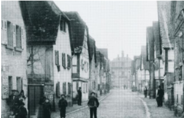
Torbau von der Schloßstraße
